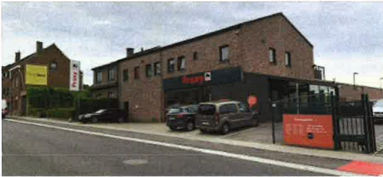
DeelRUP 2: zicht vanop de Nijvelsesteenweg op de voorgevel van de handelszaak
