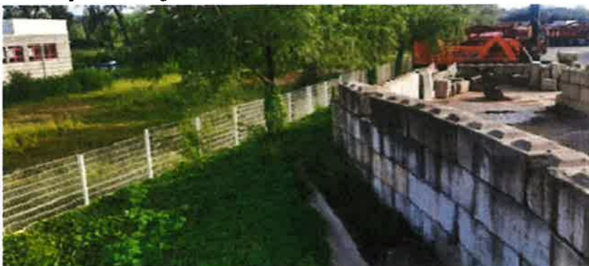
DeelRUP 1: zicht op groenbuffer langsheen oostelijke grens noordelijk deel bedrijfssite in zuidelijke richting
