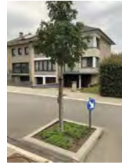
Ongelukkig aangeplante es: Afvloeiend regenwater botst op betonnen bord ipv in te sijpelen
