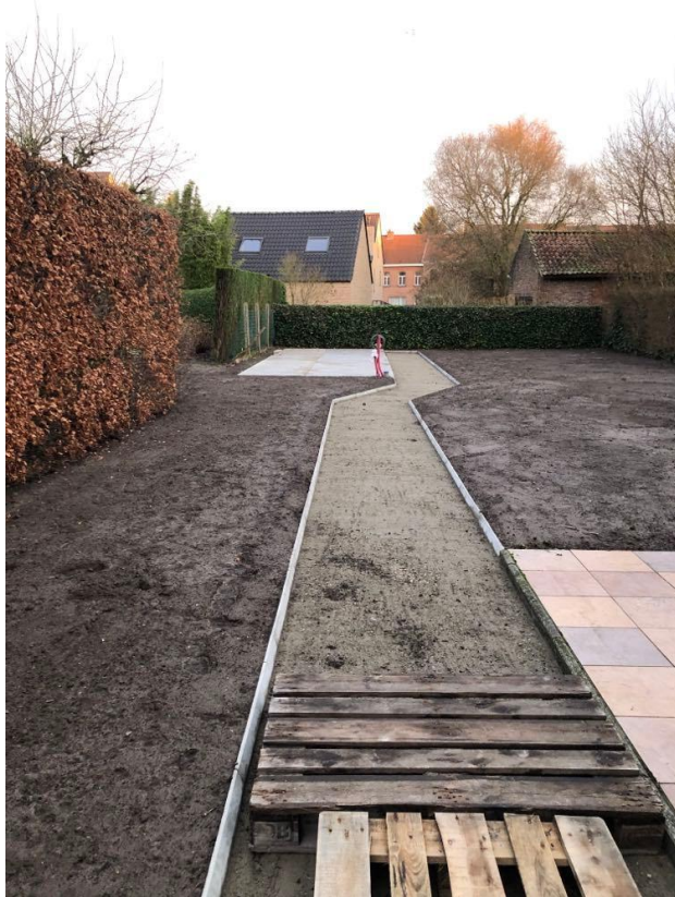
Gestabiliseerd zand -> geen noodzaak
